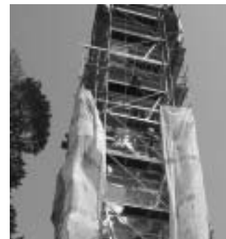
Ein Gerüst, das nichts mehr einrüstet – der Turm ist abgetragen und wird mit denselben Maßen wieder errichtet, eine interessante Aufgabe für die Zimmerleute.
