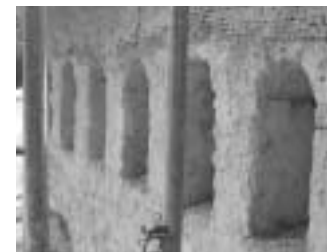
7 romanische Rundbogenfenster auf der Nord- und Südseite ließen das Licht von oben auf den Altar fallen.
