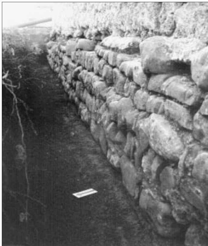
Fundament der nordseitigen romanischen Langhausmauer mit durchlaufenden Steinlagen. (Foto: F. Moosleitner)
